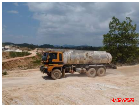
รูปที่ 11 การฉีดพรมน้ำบริเวณพื้นที่โครงการ
