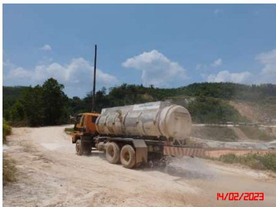
รูปที่ 11 การฉีดพรมน้ำบริเวณพื้นที่โครงการ
